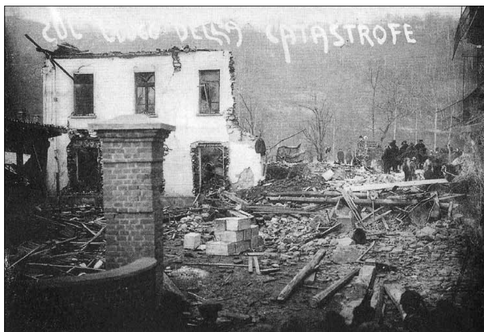
Ciò che rimase dello stabilimento Phos dopo l'esplosione.
