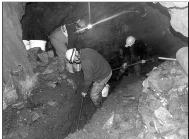
Volontari eseguono lavori di ripristino di un canale di scolo delle acque in galleria, 2013 (foto S. Bianco)
