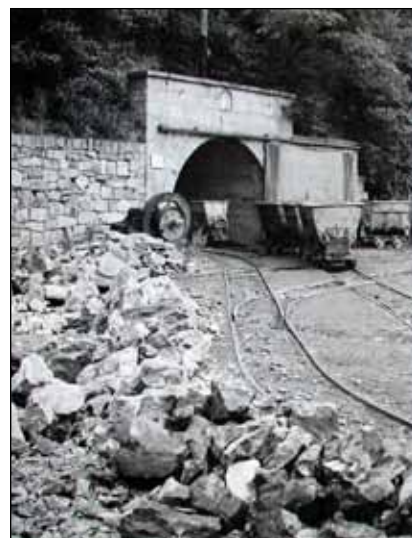
Galleria del pozzo di estrazione con vagoncini, foto anni '60, (archivio Museo Mineralogico di Traversella).
