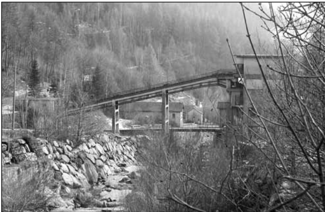
Miniera di Traversella- il piano inclinato di collegamento tra il pozzo di estrazione e il Silos, 2008 (foto S. Bianco).
