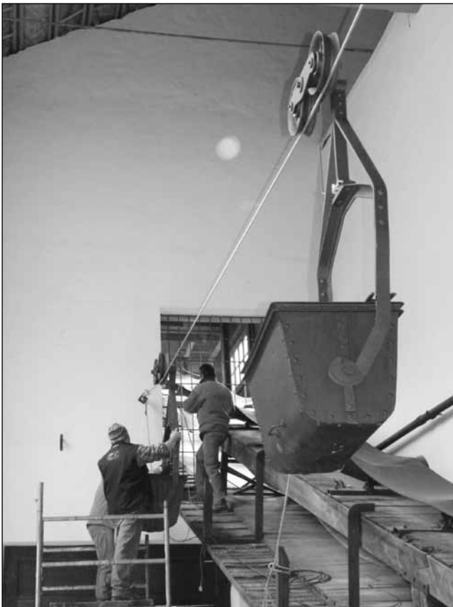
Lavori di allestimento all'ingresso del museo, 14-04-2012 (foto S. Bianco).
