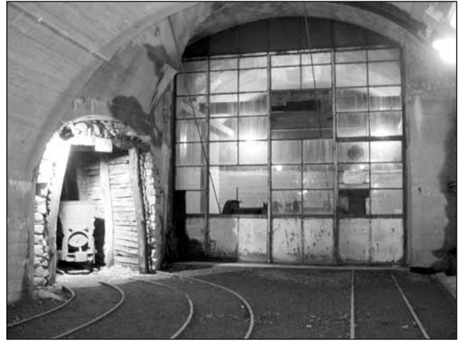
Galleria Bracco Giorgio D, l'ingresso della sala argani, 03-06-2006 (foto S. Bianco).
