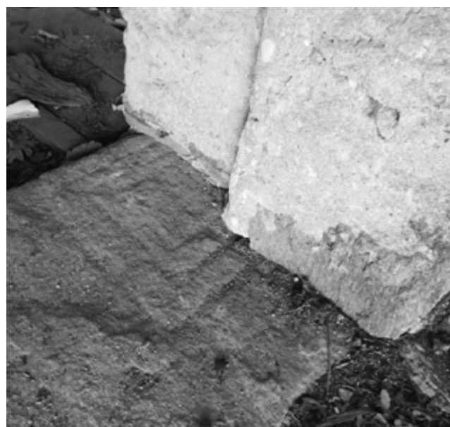
Foto 7. Particolare del filetto posto sotto lo stipite della porta della costruzione adiacente alla casa-forte
