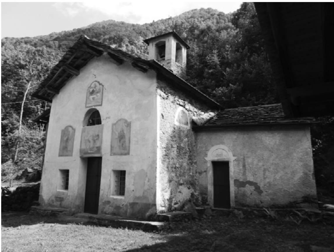
Foto 8. La Cappella Campestre (sul lato destro la sacrestia, aggiunta nel XIX secolo)
