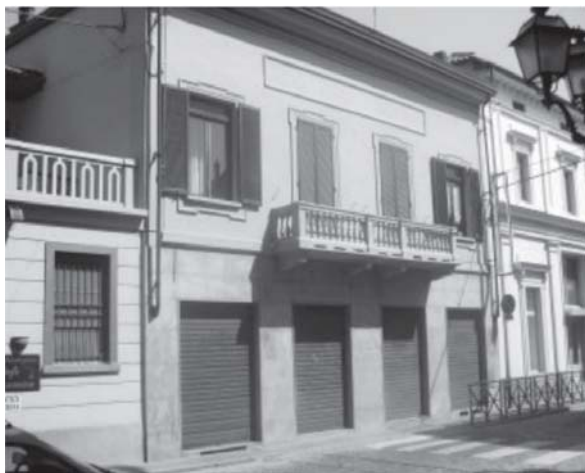
Ex Società Operaia di Castellamonte: lo stabile di Via Educ, già Via Roma
