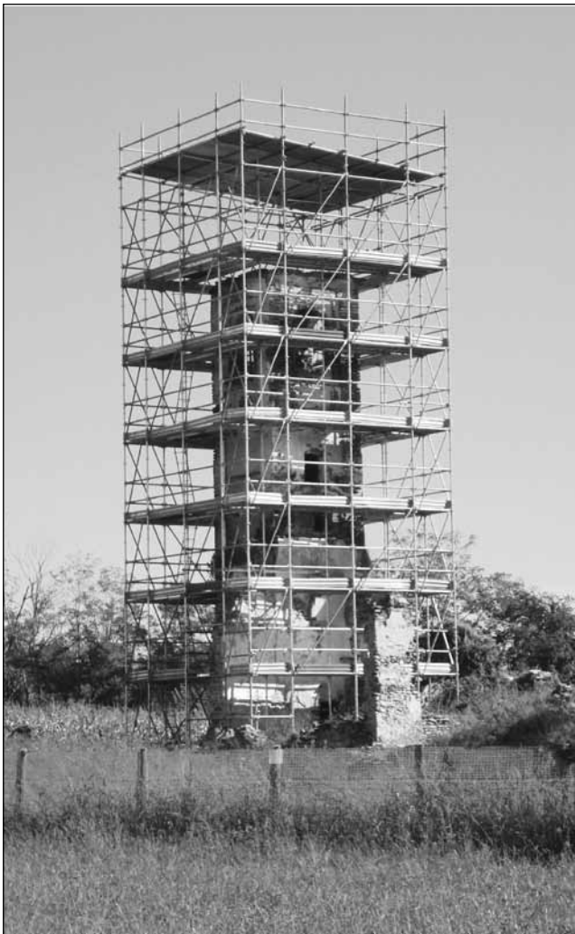
Veduta recente del sito dopo la messa in sicurezza del campanile.
