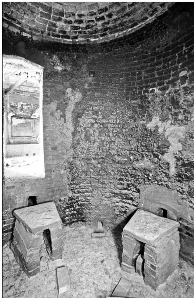
Stabilimento Stella: interno di un forno verticale a pianta circolare
