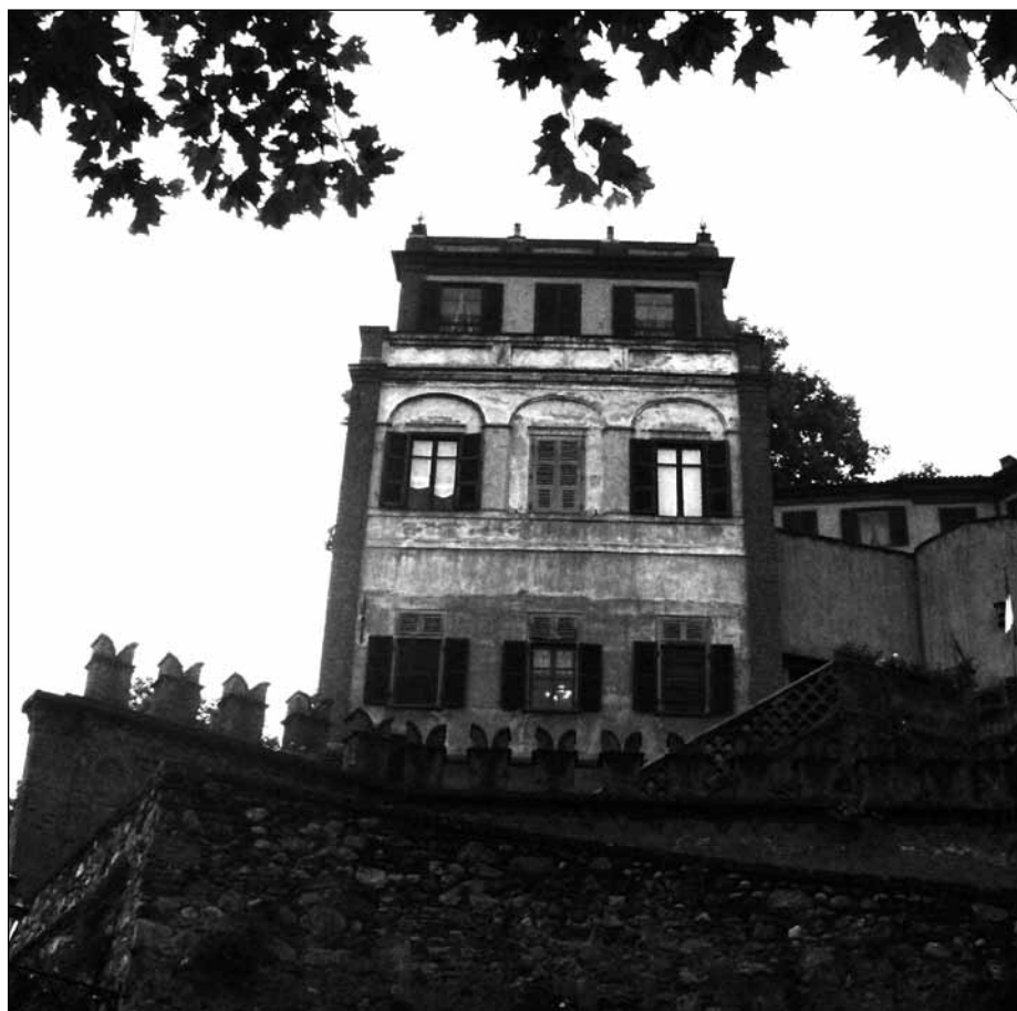
Il castello di Azeglio (lato ovest).
