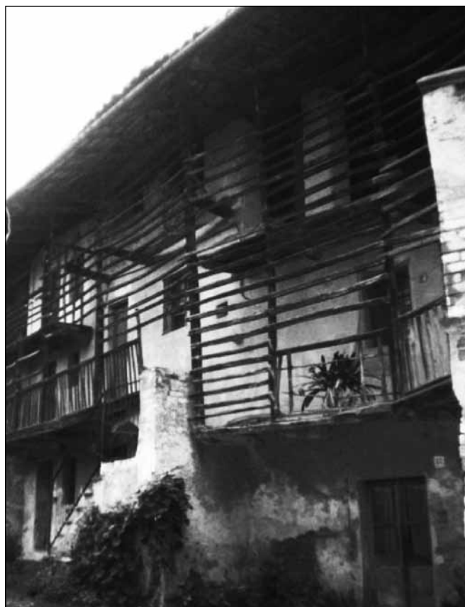
Tipici ballatoi in legno si affacciano sul cortile interno di un caseggiato del centro storico di Pertusio, in via Parrocchia
