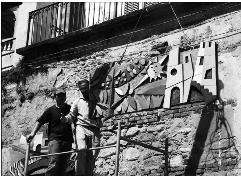
Messa in opera del pannello
